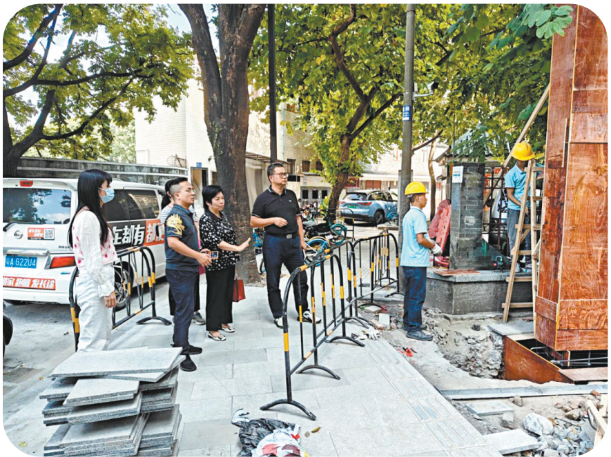
广州市海珠区纪委监委围绕“社区微改造”加强监督检查,图为该区素社街道纪工委结合前期查处街道工作人员在社区微改造工作中违反工作纪律问题,举一反三,紧盯工程质量、资金拨付等重点环节,对辖内社区微改造开展现场监督检查。
