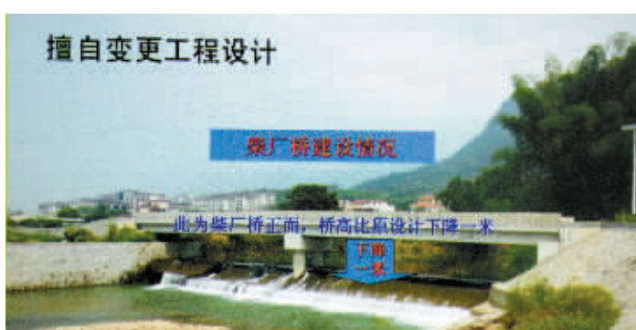
市纪委监察局抽查黄埔、番禺、花都、增城等4个区、县级市的民生水利项目时发现,增城派潭河中小河流治理项目存在问题。记者庄小龙 摄
